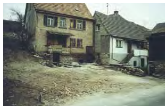
◆ Situation nach Abbruch
