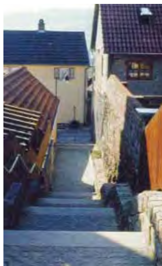
◆ Neue Treppe von Norden
